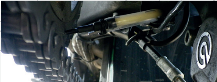
Bild 33 Montage der Ölleitung, Einarmschwinge, Düse auf Innenseite
