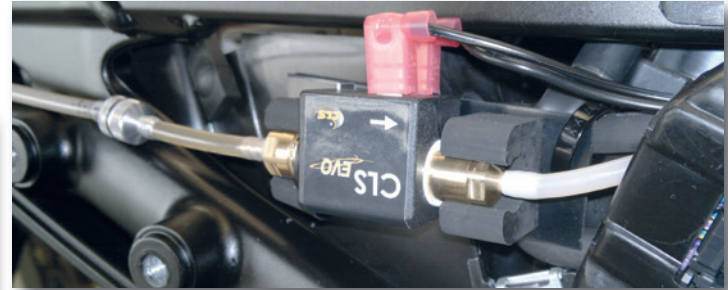
Bild 10 Gummihalter der Pumpe an der Halteplatte verklebt, Halteplatte mit Kabelbindern am Motorrad befestigt.
