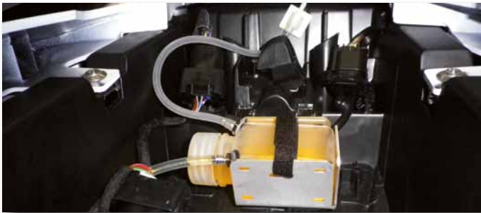
Bild 9 Belüftungsschlauch mit Kabelclip und Schlauchverbinder oberhalb des Ölstandes befestigt
